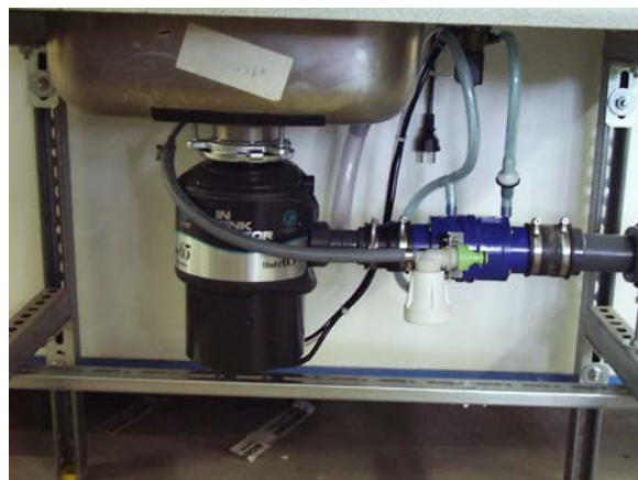
Verkleiner voor organisch keukenafval (foto: Insinkerator) met aansluiting op een vacuümrioleringsstelsel (foto: Roediger)
